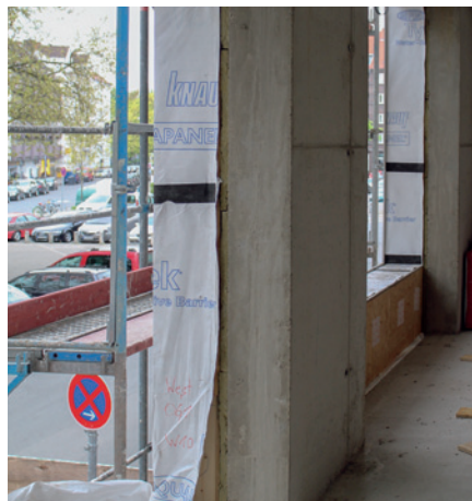
Die Holzrahmenelemente bei der Anlieferung und nach dem Einbau
