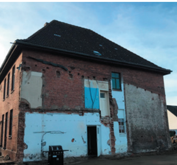
Vorher: An der Ostseite befanden sich deutliche Spuren der früheren Scheune.
